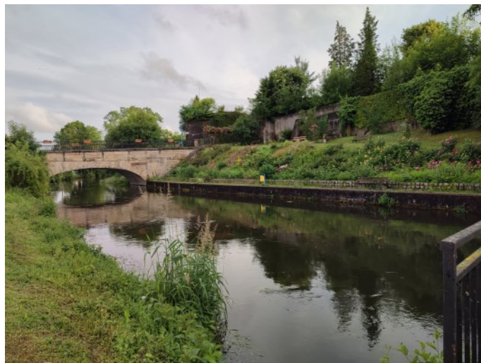
Pont de Charmes sur Moselle sur le Canal des Vosges. ©MVDM
