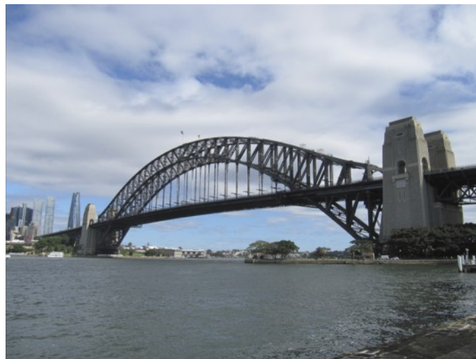
Pont Harbour Bridge de Sidney (Australie) ©EWild
