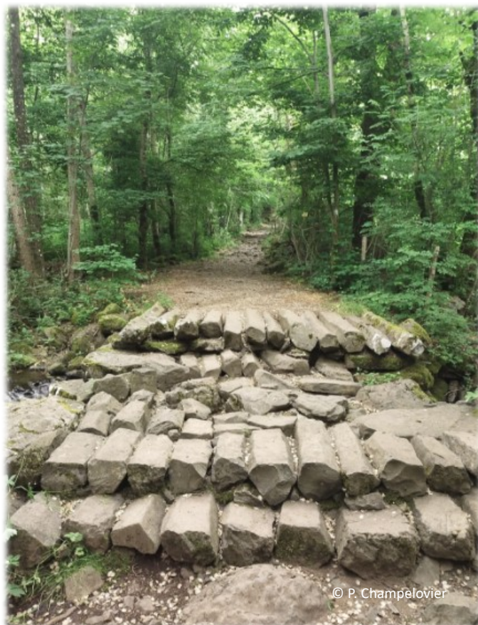
Pont en orgues basaltiques sur le ruisseau du Vayssaire, à Laguiole (Aveyron)
